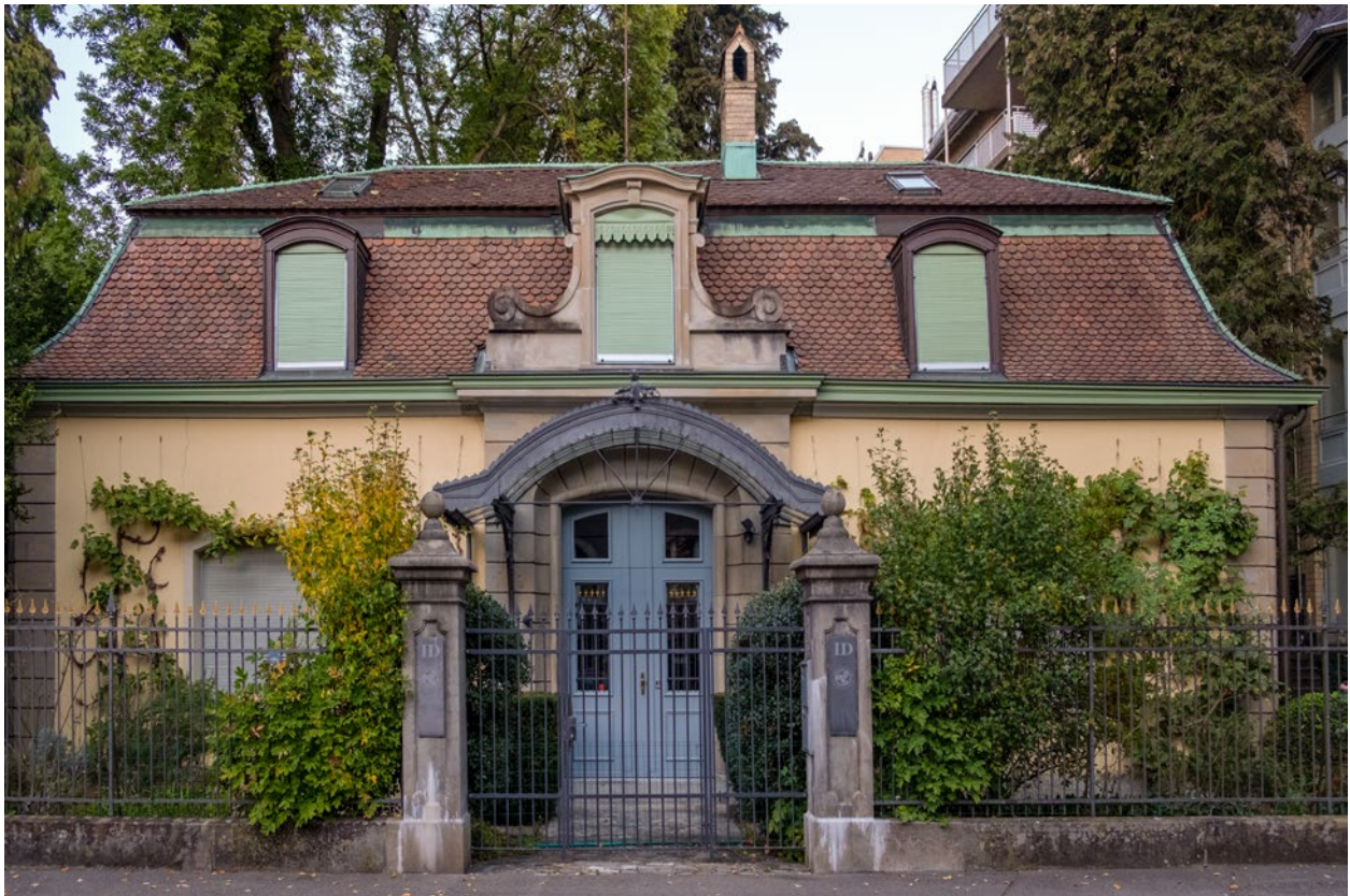
Komfortable Lage: Das Institut Dubonnet ist seit 2017 in einem Haus an der Rue Iser eingerichtet.
