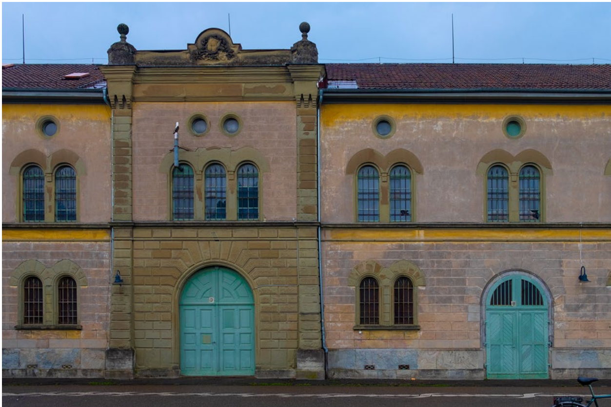
Seit 1989 wird die Kaserne nicht mehr militärisch genutzt: die Südfassade, von der Place de l’Arsenal aus.
