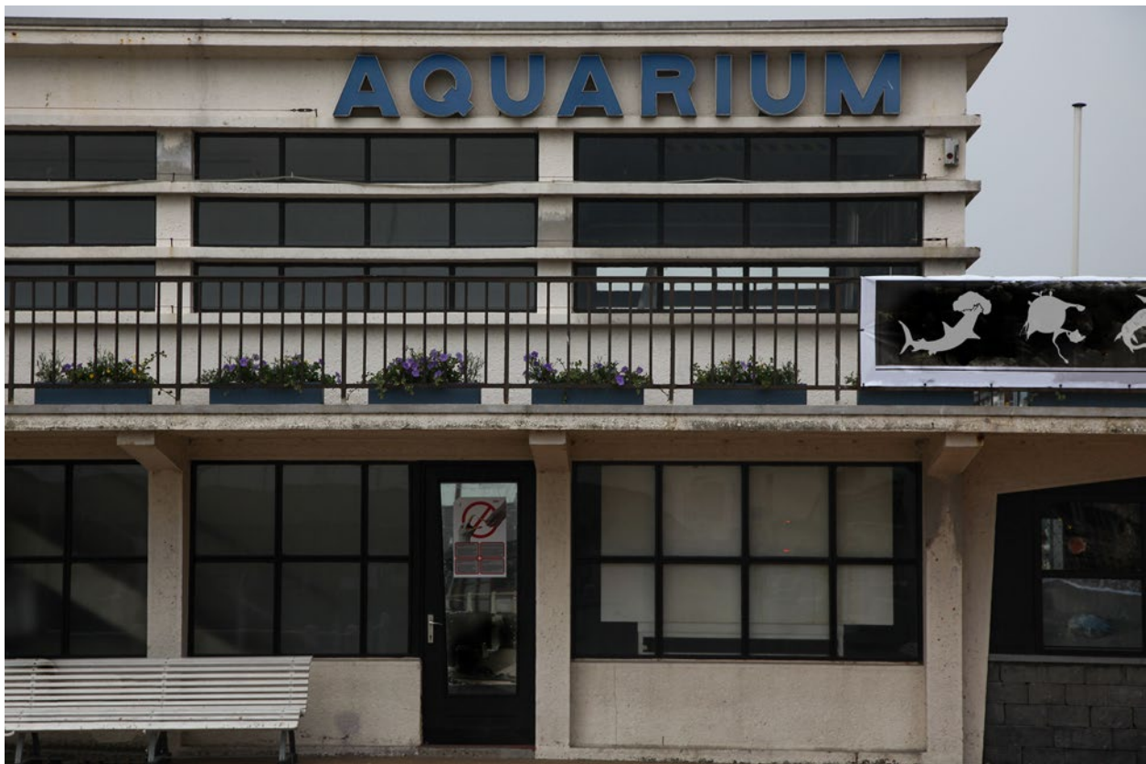
Der Stahlbetonbau (hier der Diensteingang) von 1919 wurde renoviert und um ein großes Untergeschoss erweitert.
