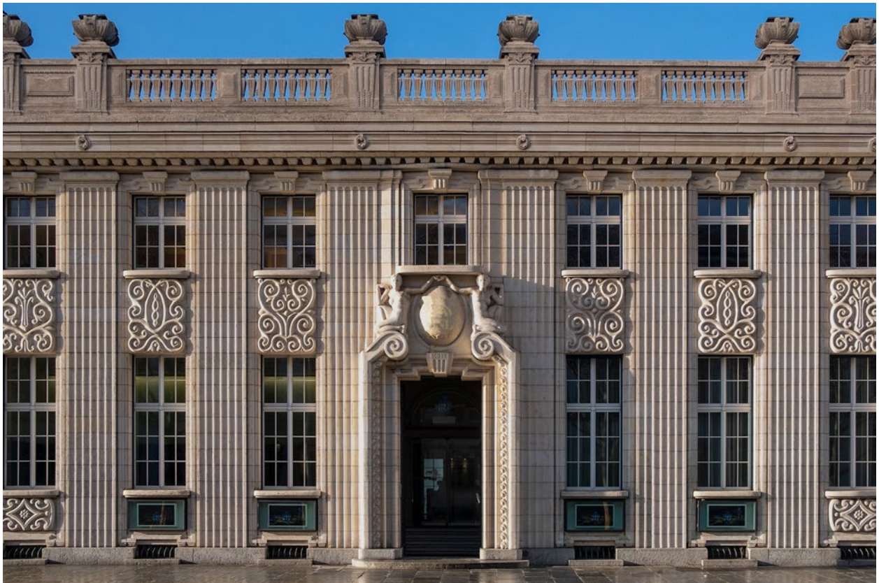
Das Hauptgebäude der Banque nationale lemusienne (BNL) gehört zu den markantesten Gebäuden im 5 ème Soutège.
