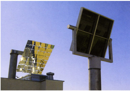
Abb. 8 Heliostaten, beide Elemente bewegen sich mit der Sonne und leiten das Licht in das Gebäude
