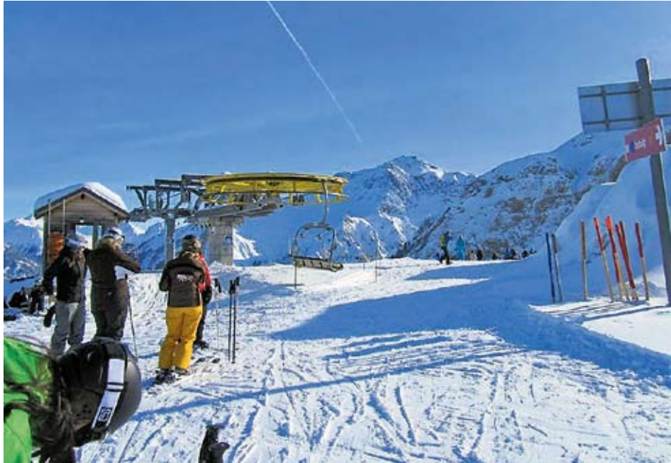
Die Bergbahnen Tschierschen GR werden mit Hilfe von Kanton und Gemeinde saniert. FRIIISCHTAILER.CH
