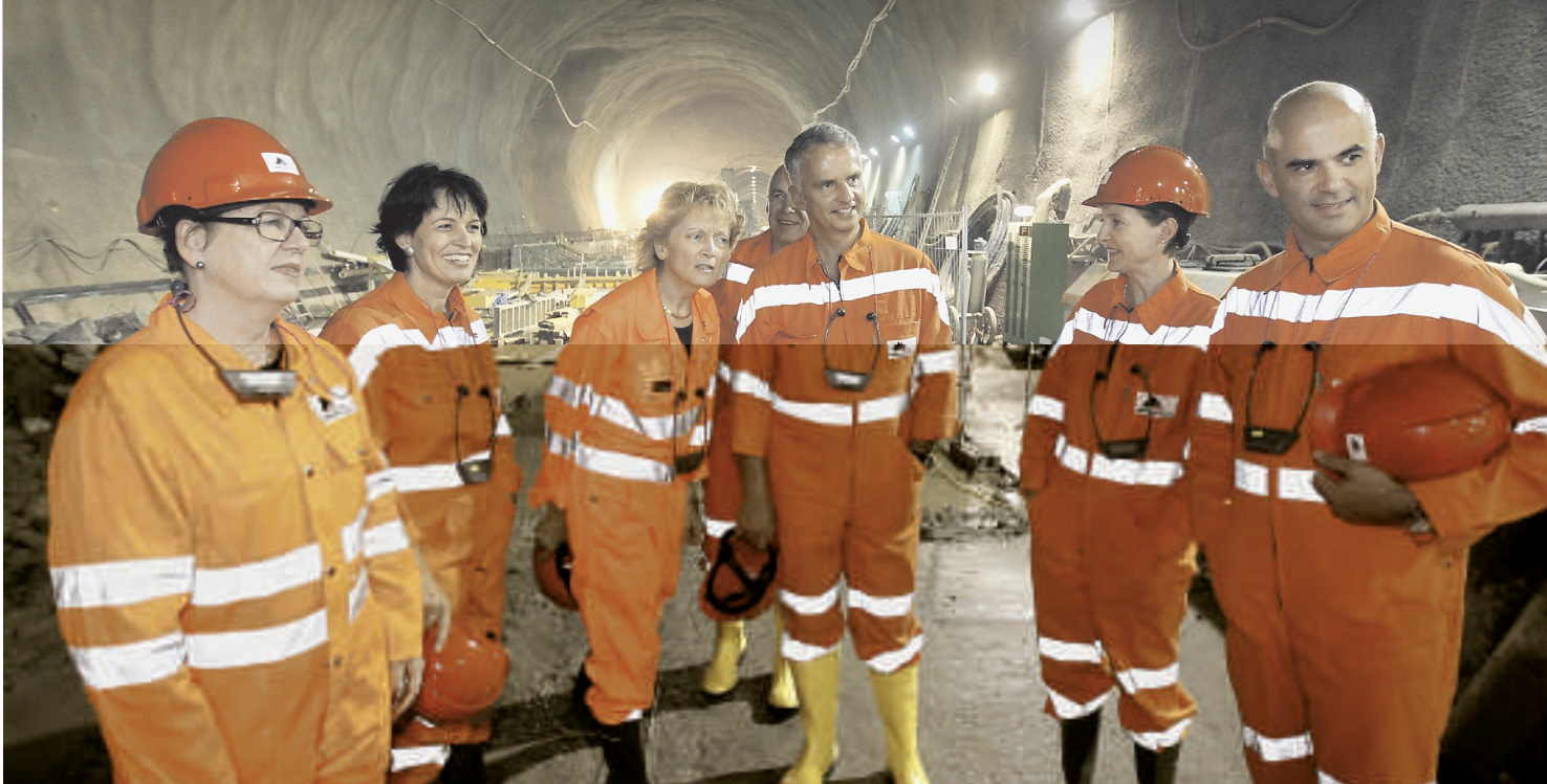
Die Landesregierung zu Besuch im Neat-Stollen, September 2012: Die Finanzierung der Bahninfrastruktur wird zum Thema FOTO: U. FLÜELER/KEY
