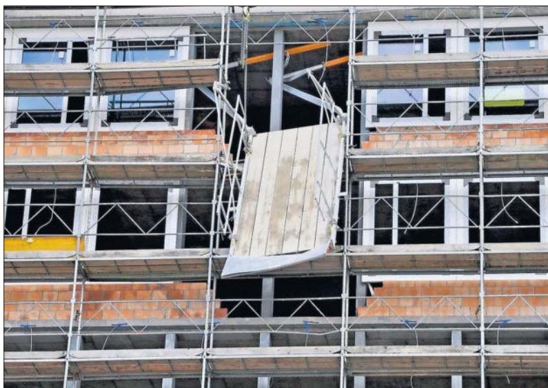
Mehr Arbeitsunfälle, wie bei diesem auf einer Baustelle in der Stadt Schaffhausen, führen zu einer Zunahme der IV-Rentner.
