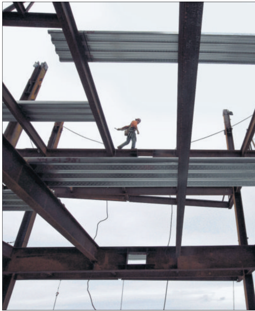
In den USA boomt die Baubranche. Im Bild der Bau eines Hochhauses.
