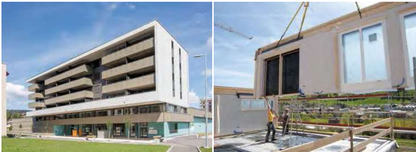
Bild links: Beispiel Wohn- und Geschäftshaus, Bulle. Heute darf ein Gebäude aus Holz bis 30 Meter Höhe ohne Sondergenehmigung gebaut werden. Bild rechts: Die Holzelementwand einer Wohnüberbauung in Einsiedeln wird montiert (Bilder: Strüby Konzept AG).
