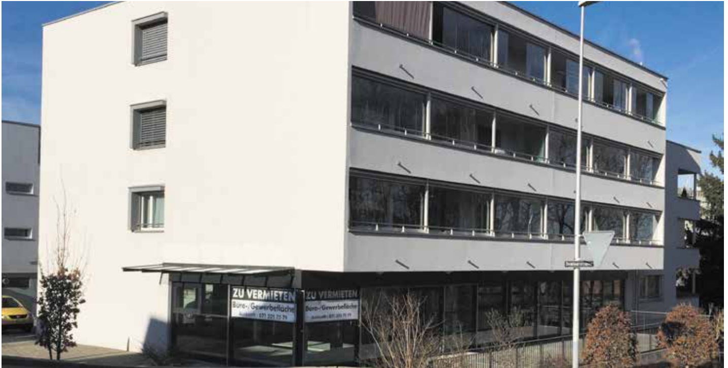
Leer stehende Büro- und Gewerbeflächen an der Herisauerstrasse in Gossau SG.
