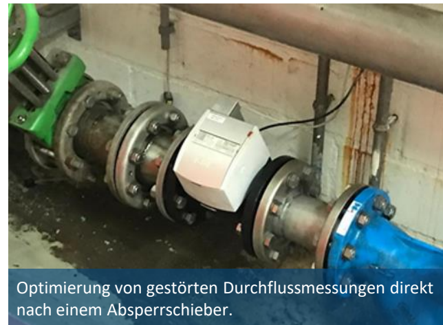
Messung mit stark wechselndem Strömungsprofil: Notwendigkeit eines großen Messbereichs
