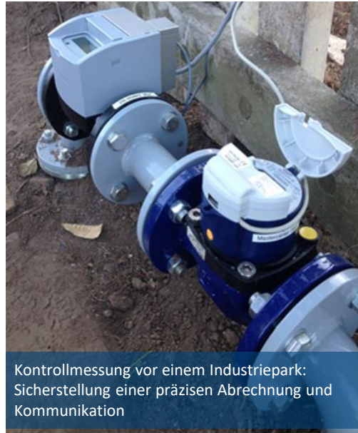
Messung mit stark wechselndem Strömungsprofil: Notwendigkeit eines großen Messbereichs
