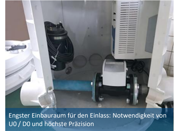
Durchflussmessungen an einer Wasserquelle mit Impuls- und Strommodul bei sehr geringen Durchflüssen
