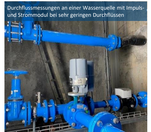
Engster Einbauraum für den Einlass: Notwendigkeit von U0 / D0 und höchste Präzision
