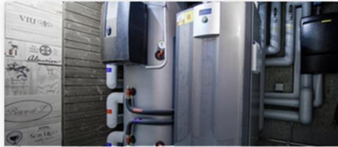
Wärmespeicher Heizungen
