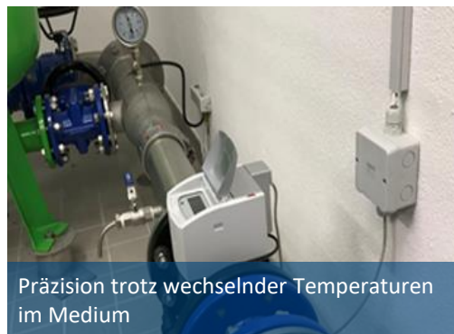
Optimierung von gestörten Durchflussmessungen direkt nach einem Absperrschieber.
